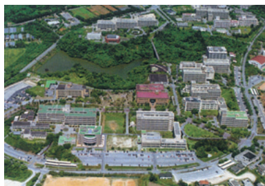
千原キャンパス全景 Aerial View of Senbaru Campus
